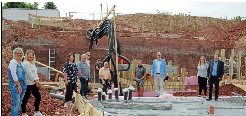
In kleinem Rahmen feierten die Beteiligten am Freitag die Grundsteinlegung für das Geras-Seniorenheim, das 75 Seniorenpflegeplätze und ein öffentlich zugängliches Café bietet. Bei der Feierstunde wurde außerdem eine Zeitkapsel eingegraben. Foto: Adrian Brosch
